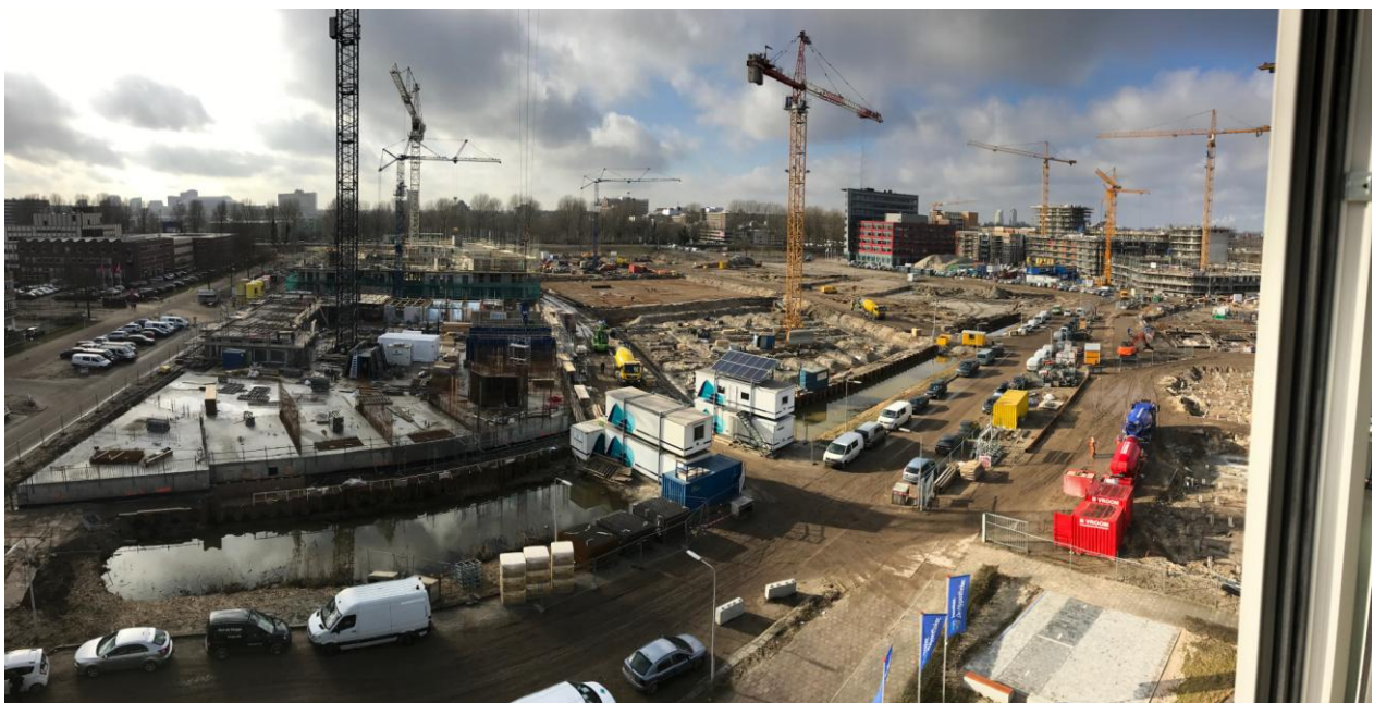
Bouwwerkzaamheden Holland Park in volle gang
