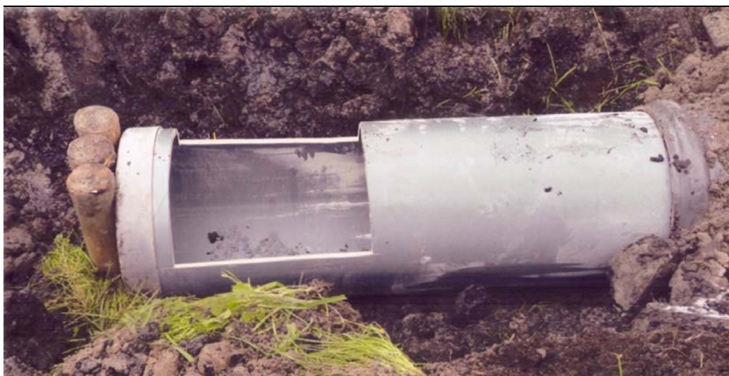
Figuur 5.1 Hemelwateruitlaat met bovenuitstroom
