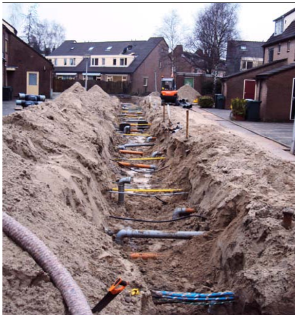
Figuur 5.2 herstel huisaansluitleidingen tijdens rioolvervanging Schelpenhoek
