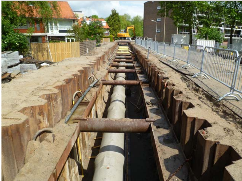
Vervanging onderheid riool Schoolstraat
