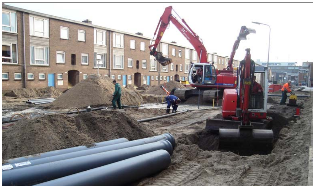
Figuur 2.7 rioolwerkzaamheden Irenestraat
