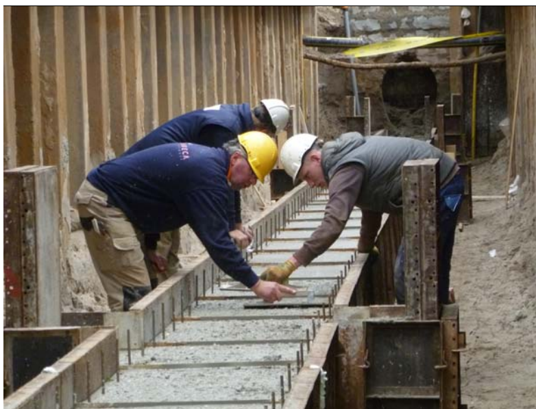
Betonnen funderingsbalk Schoolstraat
