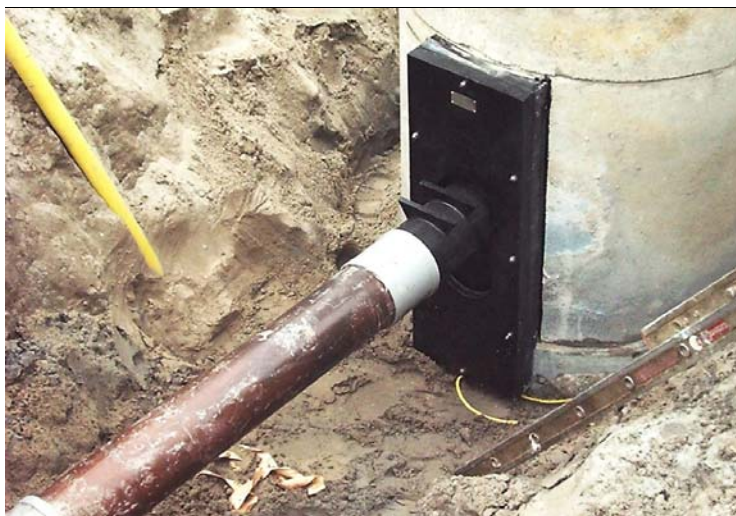
Figuur 2.6 meeschuivende lozingsconstructie op een inspectieput
