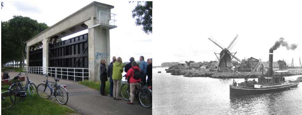
Figuur 5.8 Even uitrusten bij het Rijksmonument keersluis tussen tweede Diem en Amsterdam Rijnkanaal; Historisch aanzicht Overdiemen aan overzijde kanaal (bron: Historische Kring Diemen)
