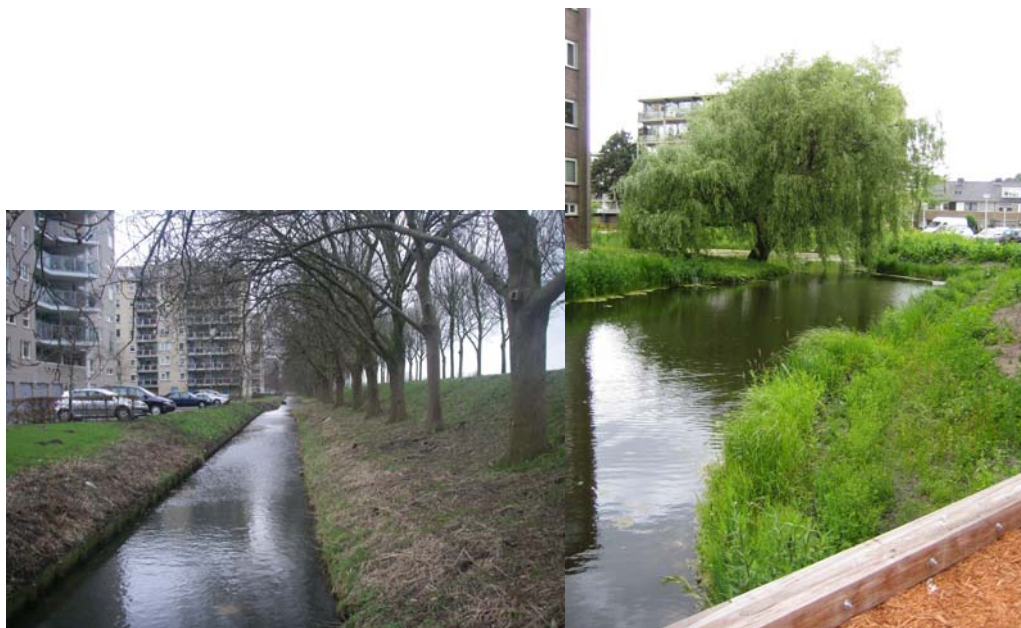
Figuur 4.3 Beschoeiing bij een sloot en aanleg natuurvriendelijke oevers Diemen Centrum
