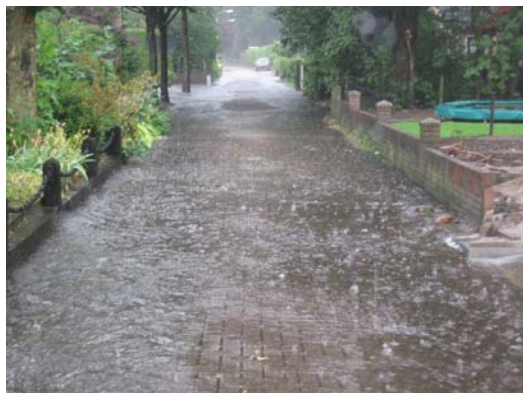
Figuur 5.5 Hier is water in het straatprofiel geborgen
