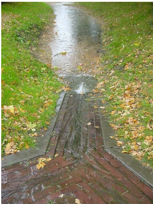
Figuur 4.2 Oppervlakkig afstromend regenwater; infiltratie in wadi
