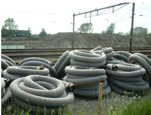
Figuur 5.3 Een stapel drainageleidingen omhuld met geotextiel voor de aanleg
