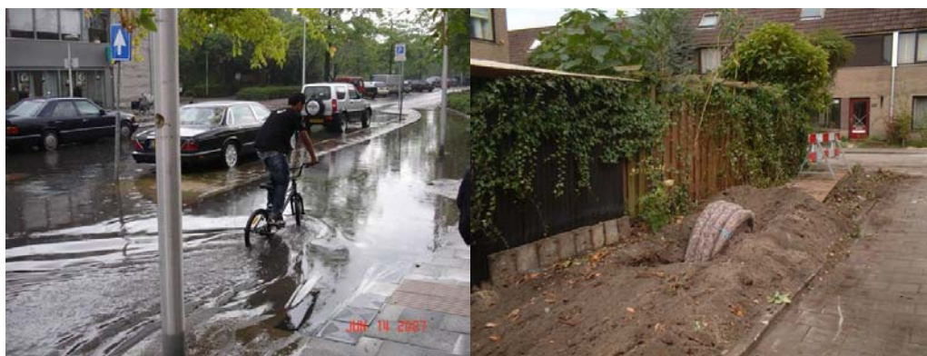
Figuur 4.1 Foto's wateroverlast door hemelwater ("water op straat"-situatie) (bron: Gemeente Diemen) en aanleg drainage in Diemen (bron: Tauw)
